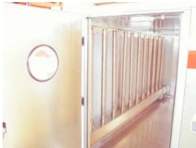
Камера Пароувлажнитель
